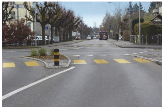
Gerade Durchfahrt beim Kreisell Jungfraustrasse – Pestalozzistrasse
