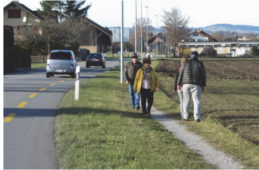
Fehlender Fussweg entlang der Pfanderstrasse
